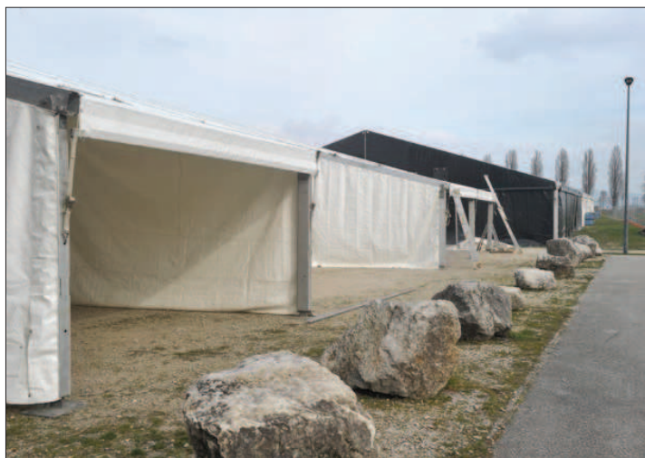
L'état du chantier, hier matin, au Parc des Rives.
