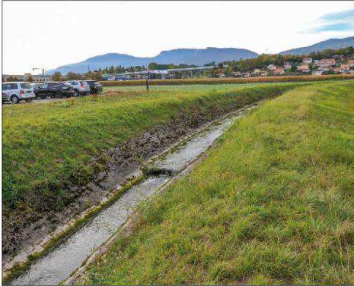
Le ruisseau de La Brinaz devrait retrouver dans un avenir proche un lit naturel et élargi, qui permettra, entre autre, de mieux canaliser le débit lors de fortes crues.
