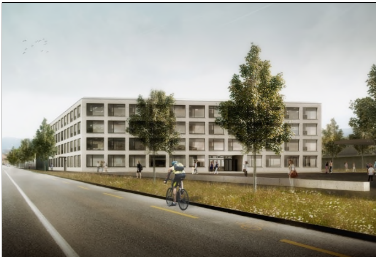
Collège : vue depuis la rue de l'Arsenal, en direction de l'Ouest / entrée principale et préau
