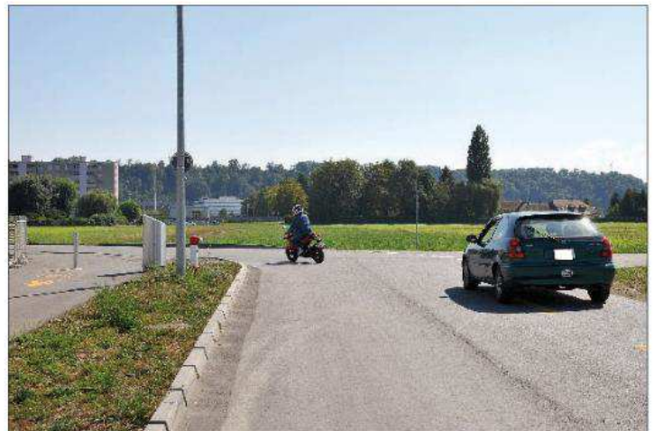
La première partie de la route, en service, sera élargie et elle sera prolongée en direction du Parc technologique (immeuble blanc au fond). Michel Duperré
