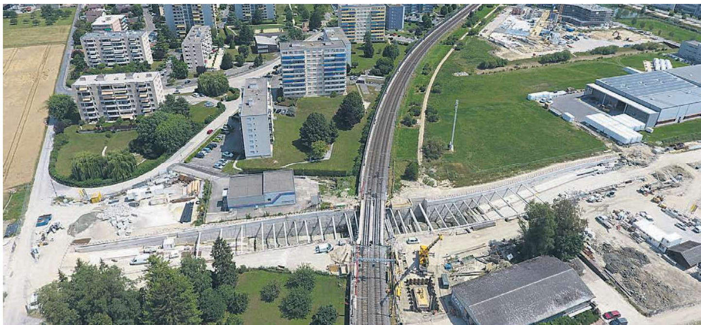
Prise récemment, cette vue aérienne permet de réaliser l'étendue des travaux et leur avancement. VILLE D'YVERDON-LES-BAINS
