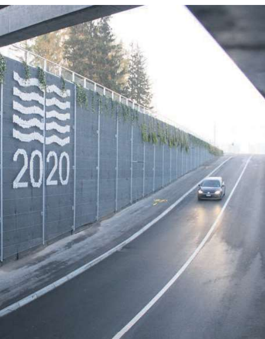
L'axe a été ouvert au trafic dès l'après-midi. Les piétons et cyclistes apprécient tout particulièrement les espaces qui ont été aménagés à leur intention.
