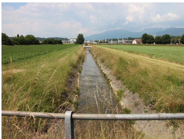
Situation avant travaux
